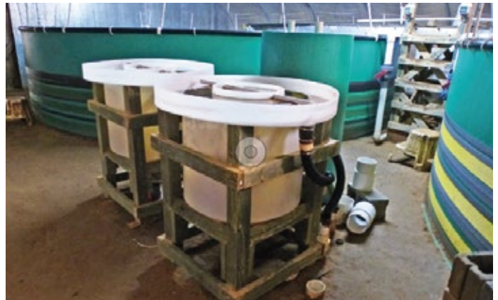
Figura 4 - Conos de sedimentación de sólidos utilizados en un RAS para la producción de peces marinos (Virginia, EE. UU.).
